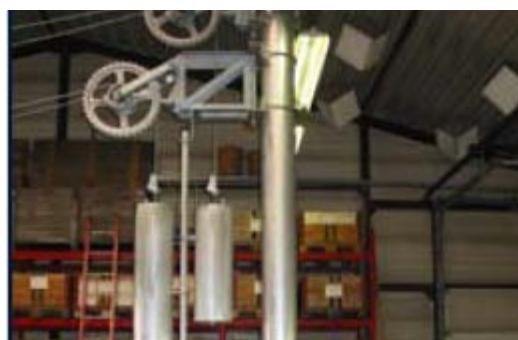
در صورت گسیختگی سیم، چرخ اینمی قفل می شود و از افتادن وزنه ها بر روی خط یا پلقتفورم قطار ممانعت می کند. بیشترین پیش بینی عمر کاری، بدون نیاز به نگهداری و تعمیر و بالاترین دقّت ممکن، این وسیله های کشش خودکار را بهترین انتخاب برای راه آهن های مدرن با نیازمندی های بالا می سازد.
